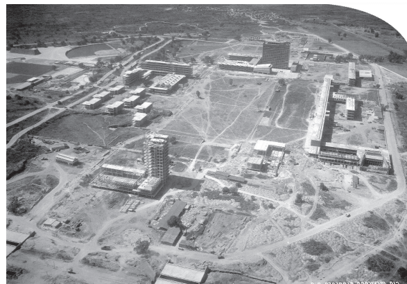
Cd. Universitaria en construcción. Años 50's Foto: Compañía Mexicana de Aerofoto. Fundación ICA
