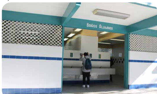
Baños, edificio "T"
