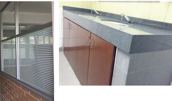
icina en el edificio "N". sanitarios edificio de la Dirección.
